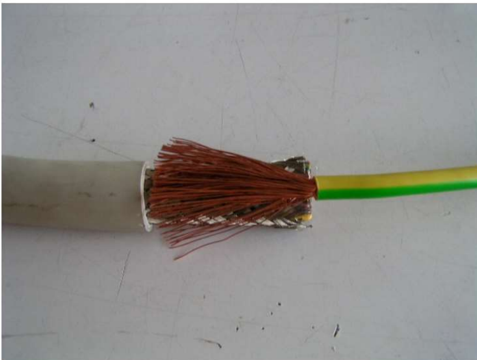
Bild. 3.2: Drähte des PE auseinander fächern und auf die Schirmung legen.
