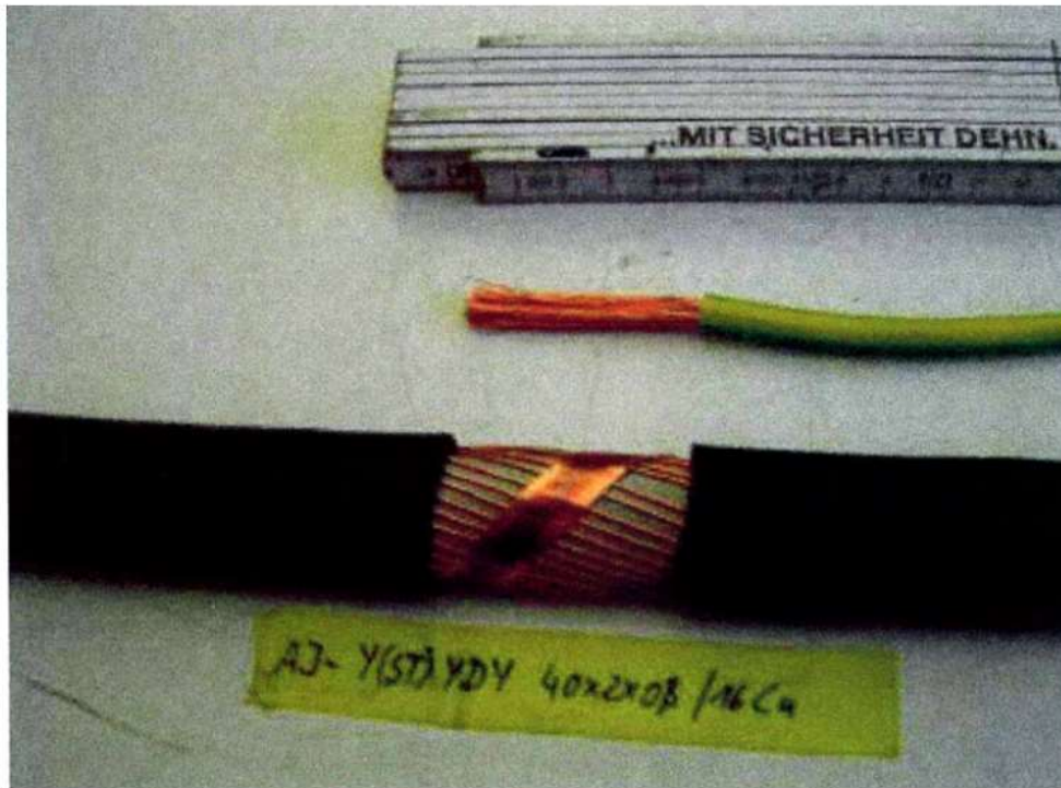
Bild. 2.1: z.B. Kabel AJ-Y(ST)YDY 40x2x0.8/16 Cu für Kontakt-Rollfeder SA KRF 29 V2A und PE 1x16 mm 2 (mehrdrätig ) ca. 5 cm abisolieren.
