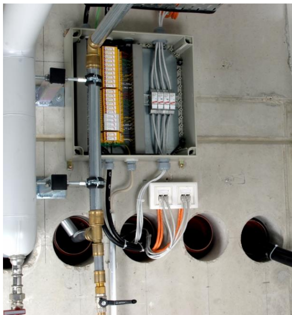
Obrázek 2 Příklad instalace univerzálního svodič pro síť Ethernet
