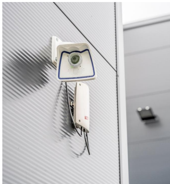
Obrázek 2 Příklad instalace univerzálního svodič pro síť Ethernet
