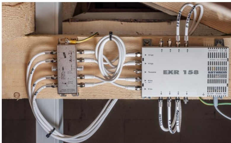
Obrázek 3 Příklad ochrany koaxiálního vedení na vstupu do objektu
