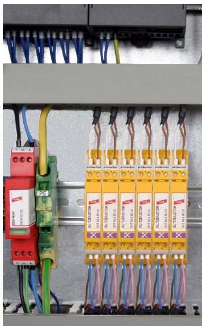
Obrázek 1 Příklad ochrany části systému EZS
