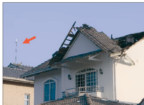
Obr. 5. Škoda na budově v Malajsi chráněné jímacím zařízením ESE
