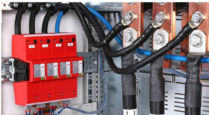
Obr. 7 Vzorové zapojení svodiče bleskových proudů a přepětí DEHNvenCI, obj. č. 961200
