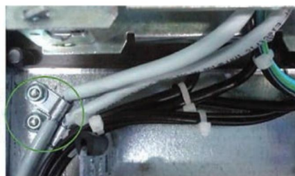
Obr. 2 Uzemnění stínění kabelů kovovými příchytkami
