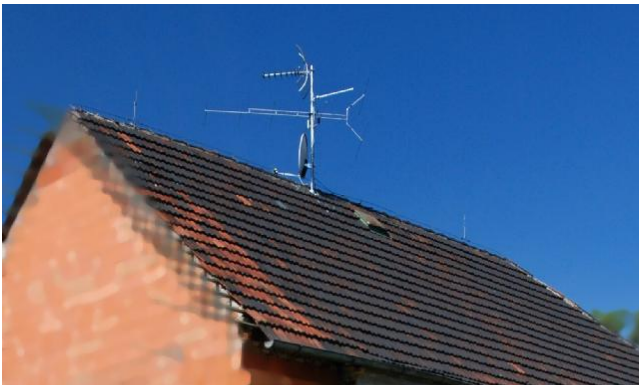
Obr. 2.1 Příklad klasické instalace anténních systémů “po staru”
