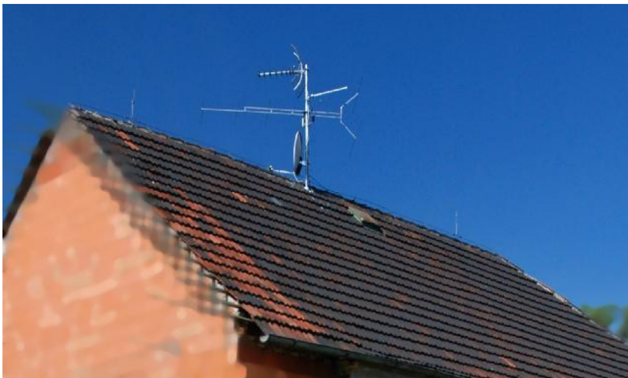
Obr. 2.1 Příklad klasické instalace anténních systémů “po staru”
