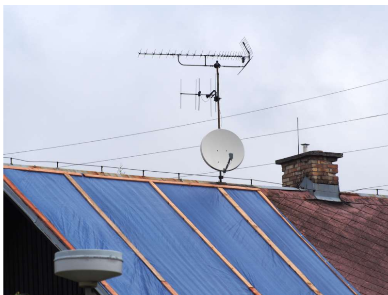
Obr. 3b. Detail špatné instalace TV antén (propojení s hromosvodem).
