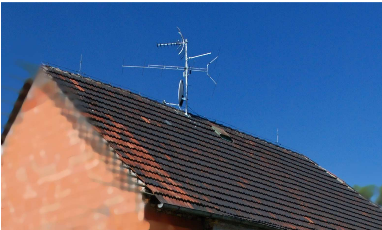
Obr. 2.1 Příklad instalace anténních systémů “po staru” a špatně.
